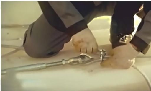
Рисунок 5. Заделка троса
